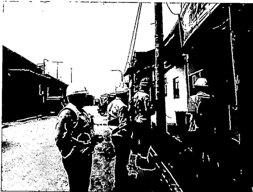
CONTINUACION DE TRABAJOS DE REPLANTEO DE TRAZO DE CABLES
