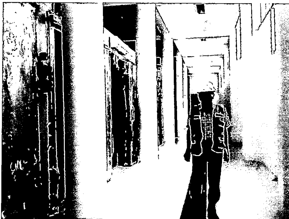
VISTA DEL CORREDOR ENTRE LAS CAMARAS FRIGORIFICAS Y LOS PRODUCTORES DE HIELO
