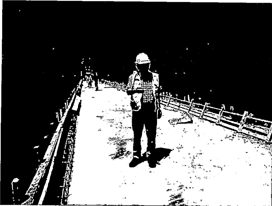
SUPERVISOR EN LOSA DEL MUELLE EJE- 163-164
