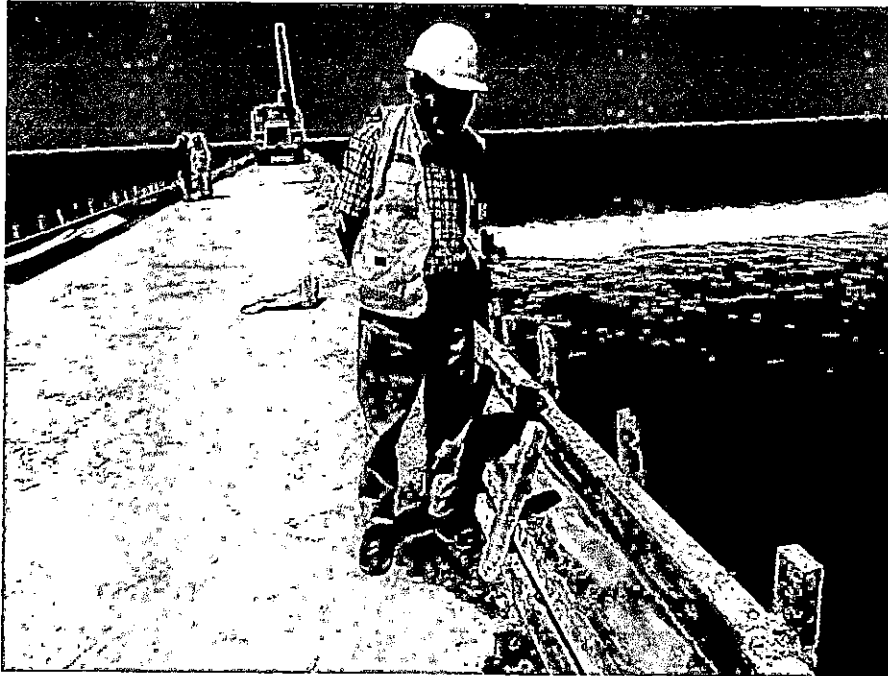
SUPERVISOR VERIFICANDO TRABAJOS
